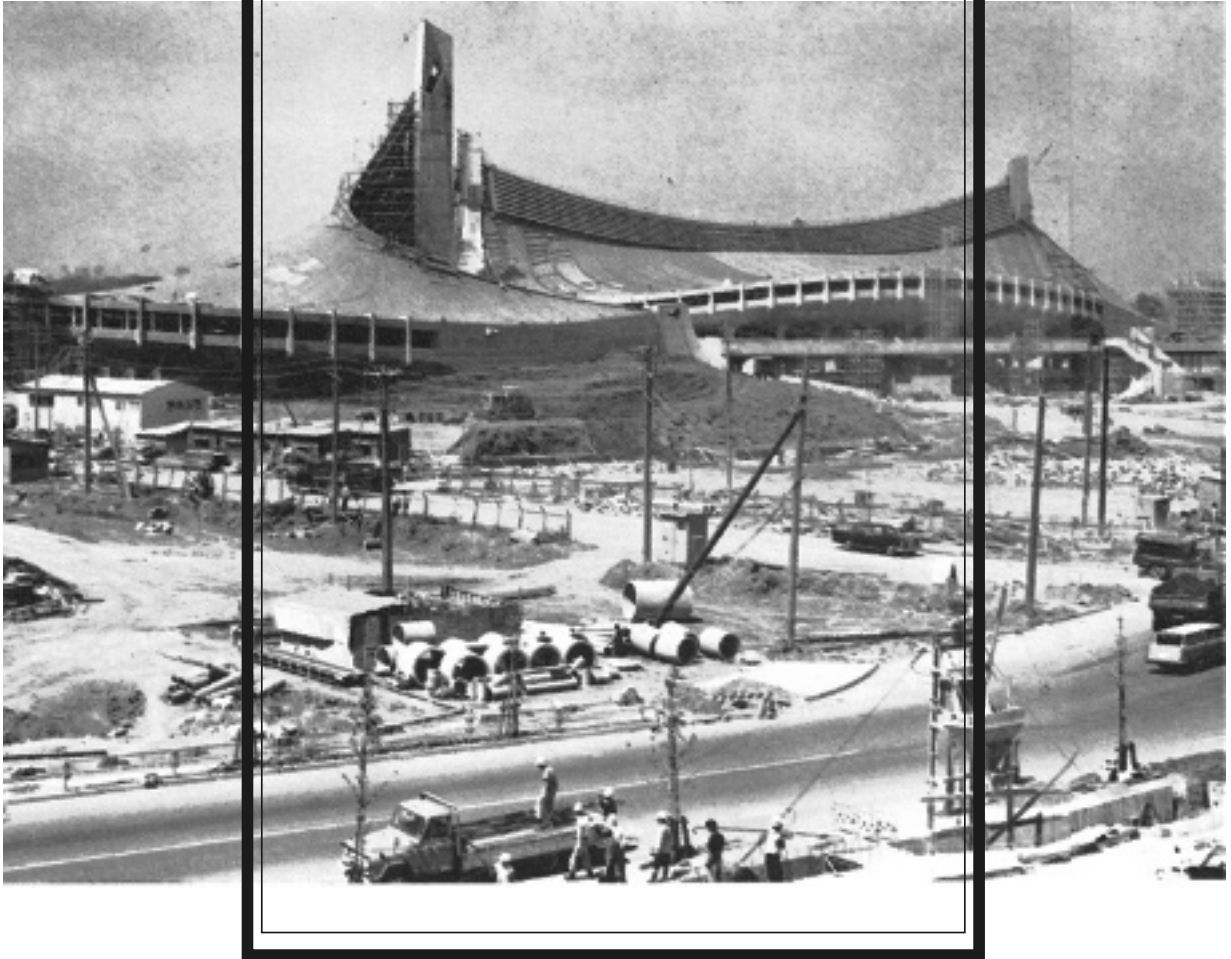
「オリンピック関連街路完成記念パンフレット」(提供：東京都建設局)より
