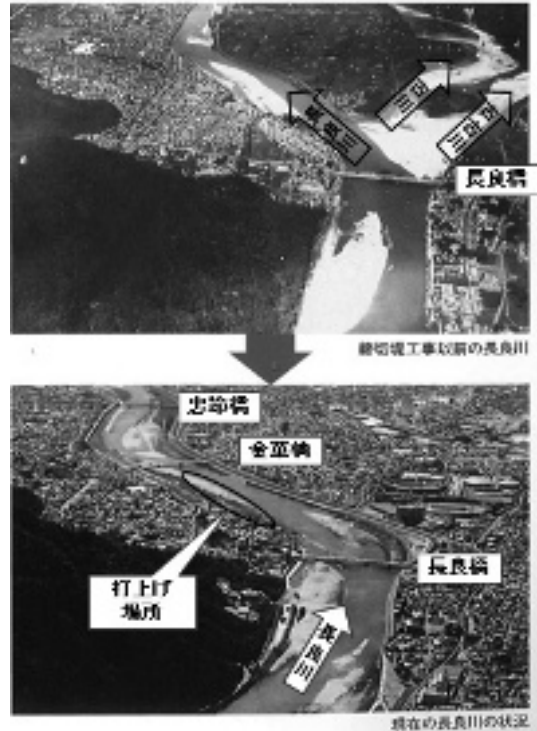
写真-1 改修前後の長良川（会場付近）
