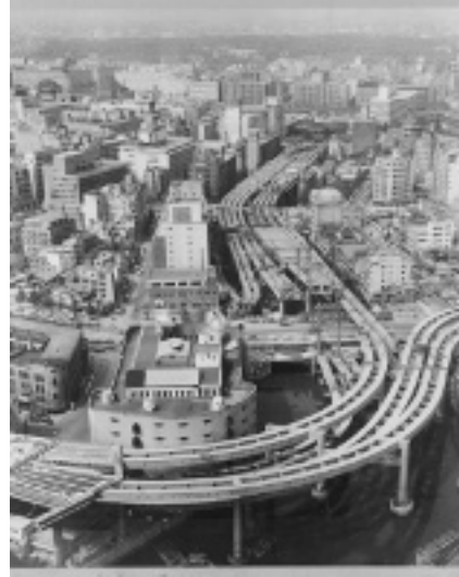
写真-5 建設進む首都高速道路1号線 (昭和37年)
