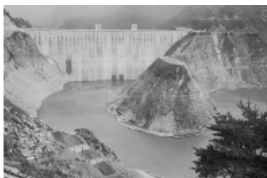
写真-2 底をついた小川内ダム（昭和36年）
